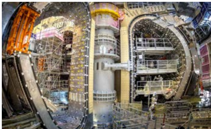
Il cantiere per la costruzione del TOKAMAK: visibili i magneti toroidali. La dimensione delle persone rende possibile comprendere la dimensione della costruzione
